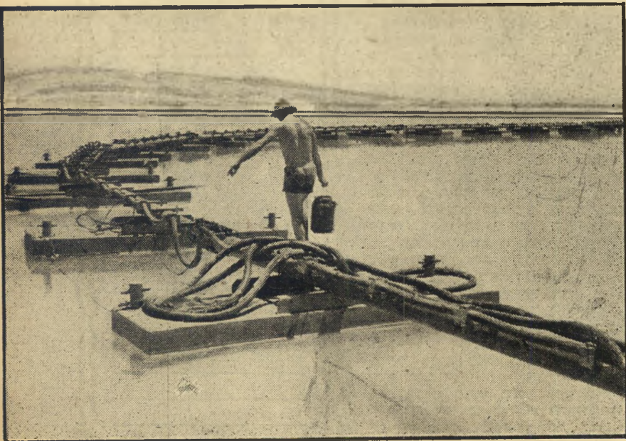
קו החזית של מיבצע האשלג עובר בבריכות-הקארנאלים הענקיות. כמהלך על חבל, מטפס אחד מעובדי הדוברות על קו-הצינור השט על פני מי האשלג הלבנים כצבע מישקע הקארנאלים בתחתיתם. בצינור נשאבת תמיסת-הקארנאלים מן הדבורה אל המפעל. שם היא עוברת בתהליך הזיקוק. הליכה זו מסוכנת, עלולה להסתיים בנפילה למעמקי הבריכה.
